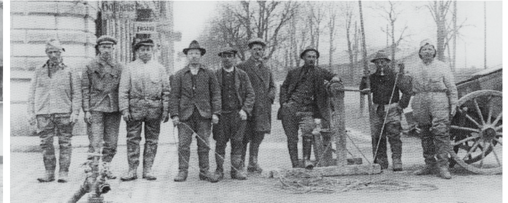
Die städtische Kanalbrigade nahe dem Ostbahnhof in den 30er-Jahren. Pfeifenrauch sollte den Gestank neutralisieren.
