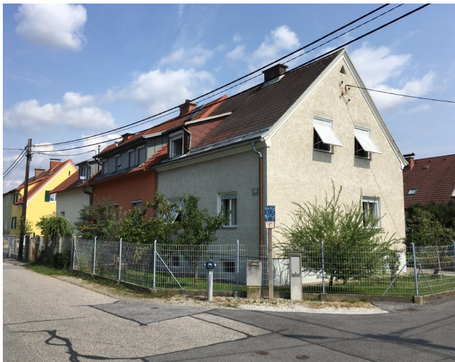
Reihenhaustyp Süd-Ost-Siedler Straße
